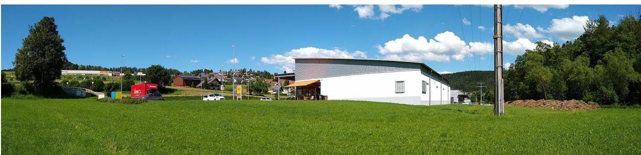
Abb. 6: Blick auf die Erweiterungsfläche aus südwestlicher Richtung.
