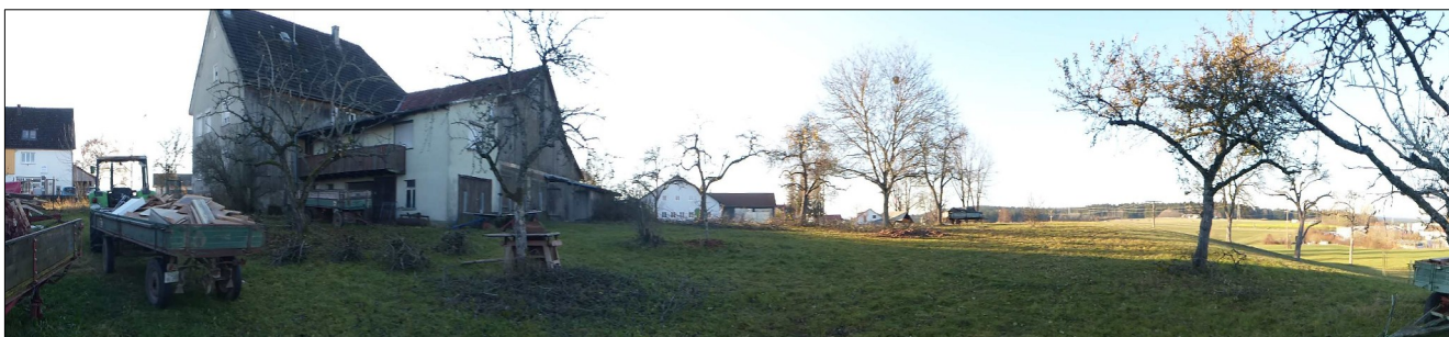
Ansicht aus Nordosten auf das alte nicht mehr genutztes Wohngebäude mit angebauten Schuppen und nach Norden vorgelagertem Streuobstbestand (4)
