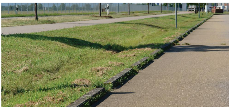
Abbildung 55: Auf Lücke gesetzte Bordsteine zur Ableitung von Straßenoberflächenwasser
