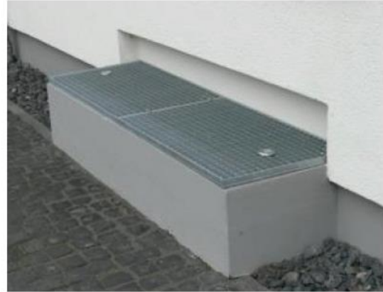
Abbildung 54: Erhöhter Eingang mit abgedichteter Tür, erhöhter Lichtschart mit Abdeckmöglichkeiten
