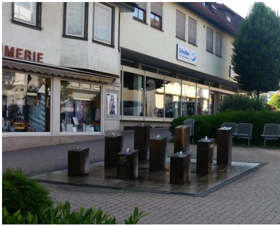
Wasser zur Kühlung, Dornstetten
